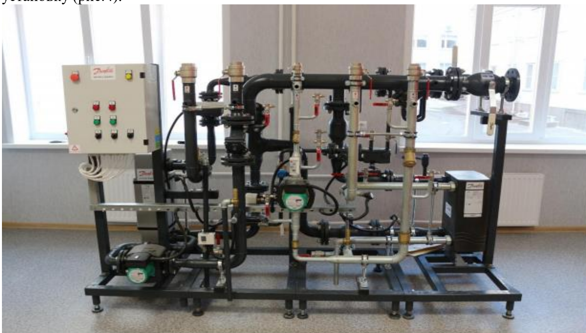
Рис.4 Блочный тепловой пункт Danfoss
