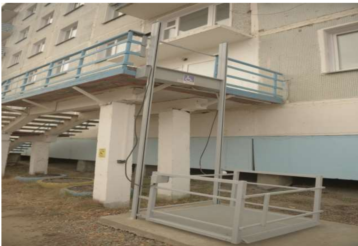
В студенческих общежитиях № 1 и 2 установлены вертикальные подъемники для безопасного преодоления крыльца (рис. 12).
