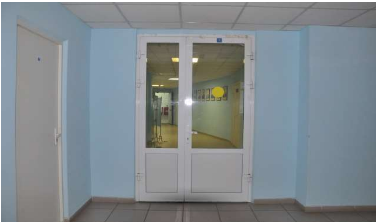
Контрастная маркировка позволяет слабовидящим получать информацию о доступности для них объектов, изображенных на знаках о наличии препятствия (рис. 15).
