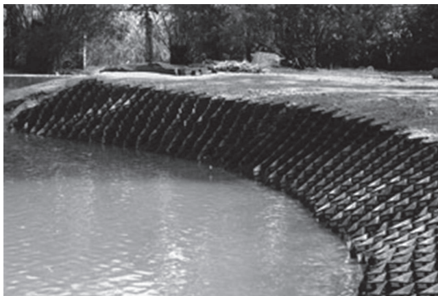
Рисунок 3 – применение георешетки для берегозащиты
