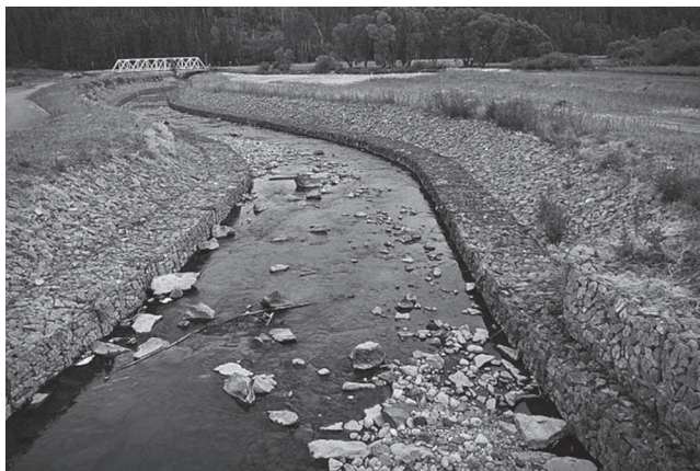
Рисунок 2 – Укрепление берега габионными конструкциями
